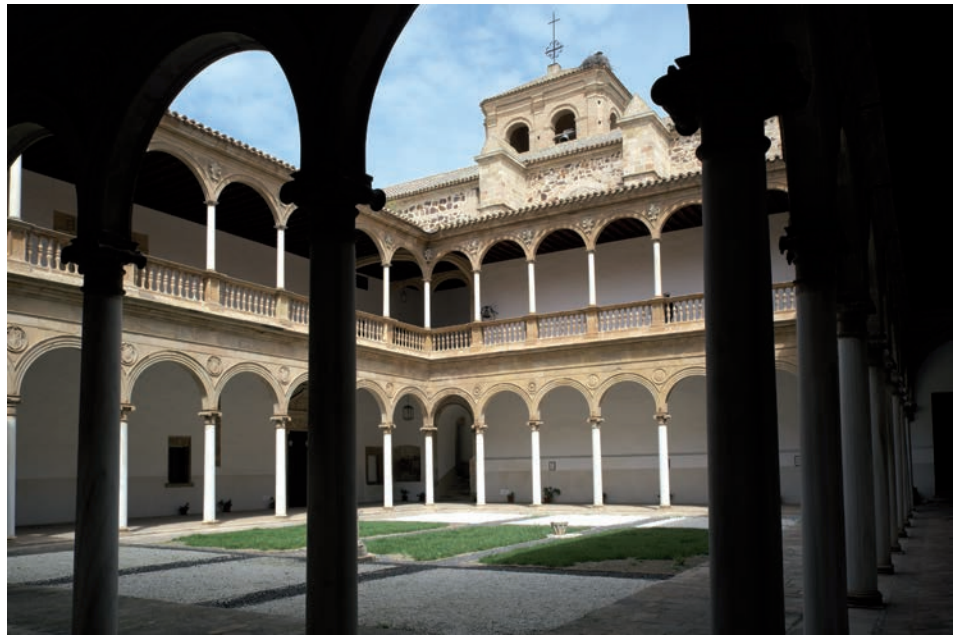
Claustro del Convento, un edificio cuya construcción se remonta al siglo XVI. Foto: GFreihalter
